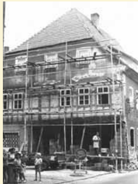
Gebäudesanierung des ehemaligen Gasthofs Zum gold'nen Stern um 1980, Foto: W. Bauer
