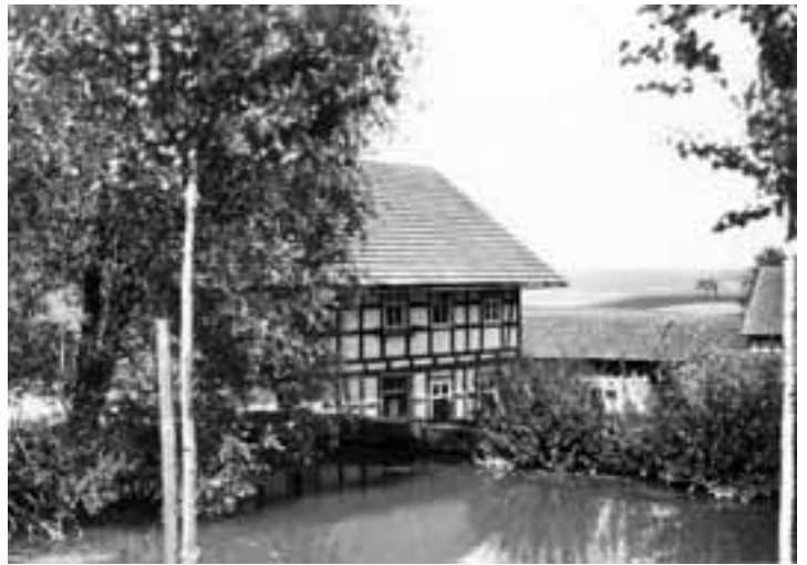
steht noch die Riether Mühle von Familie Vey, die zu DDR-Zeiten abgerissen wurde, weil man in Nähe des Eisernen Vorhangs keine Gebäude wegen Fluchtgefahr stehen haben wollt. Repro-Foto: Gerhard Schmidt
