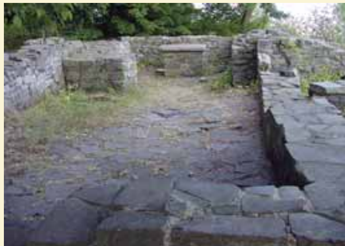
So viel ist heute noch von der Bergkirche St Michael übrig.
