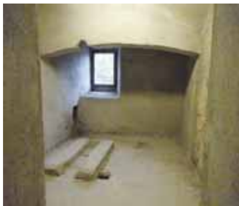
Der Rauchfang in der Kochstube deutet auf die einstige offene Feuerstelle hin.
